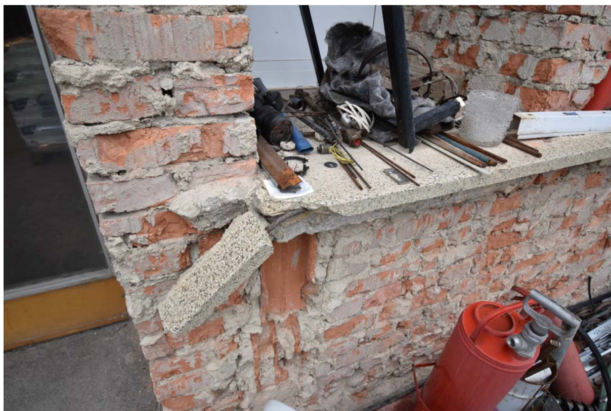
Obrázek 03 – příklad zničeného teracového parapetu
