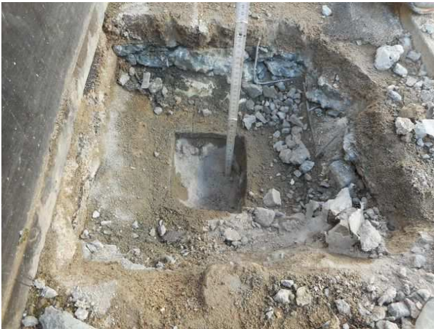
foto/17/ Pohled provedenou sondou
