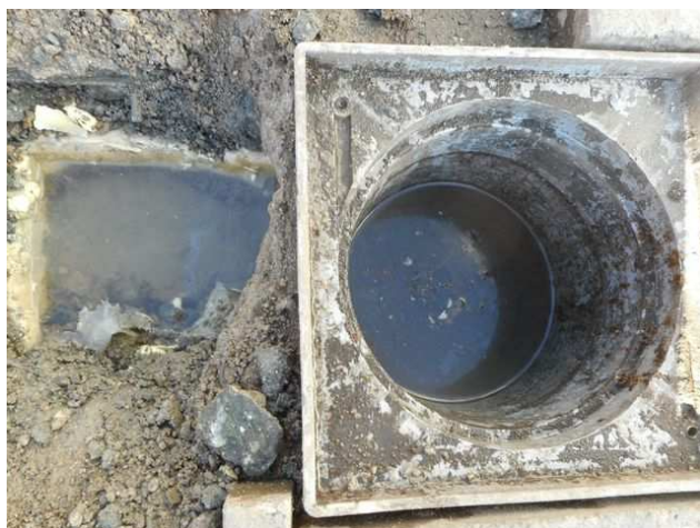
foto/26/ Pohled na již ustálenou hladinu ve vtoku a ve skladbě terasy
