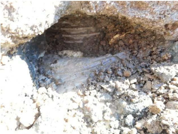
foto/23/ Pohled na zanesení boční perforované části vtoku
