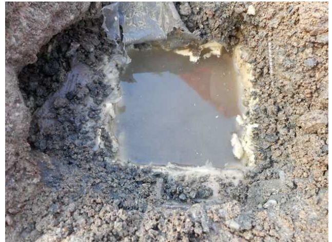
foto/24/ Pohled na zabudovanou vodu ve skladbě terasy
