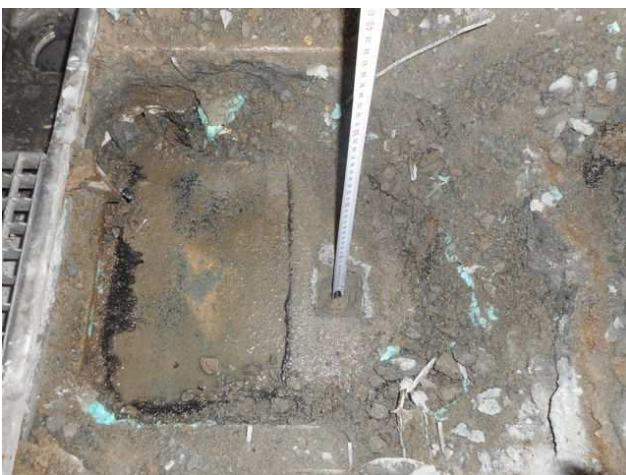
foto/19/ Pohled provedenou sondou
