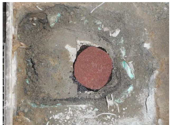
foto/20/ Pohled na zapravenou sondu
