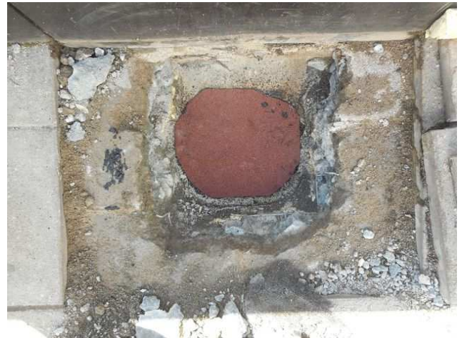
foto/18/ Pohled na zapravenou sondu
