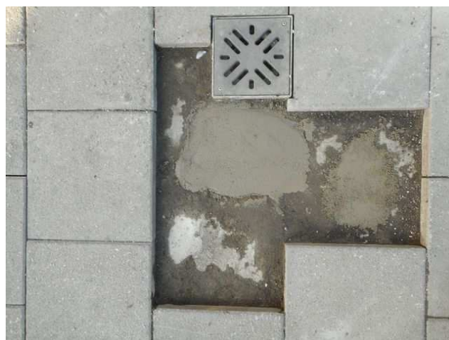
foto/16/ Pohled na zapravenou sondu
