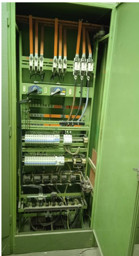
Stávající vývodní pole ( 2 ) stávajícího rozvaděče RM2, které je předmětem rekonstrukce.
