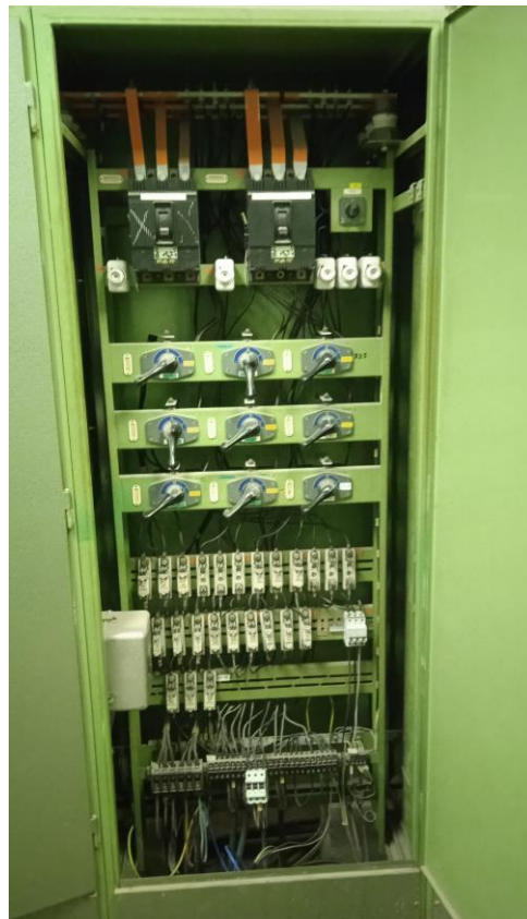
Stávající vývodní pole ( 3 ) stávajícího rozvaděče RM2, které je předmětem rekonstrukce.
