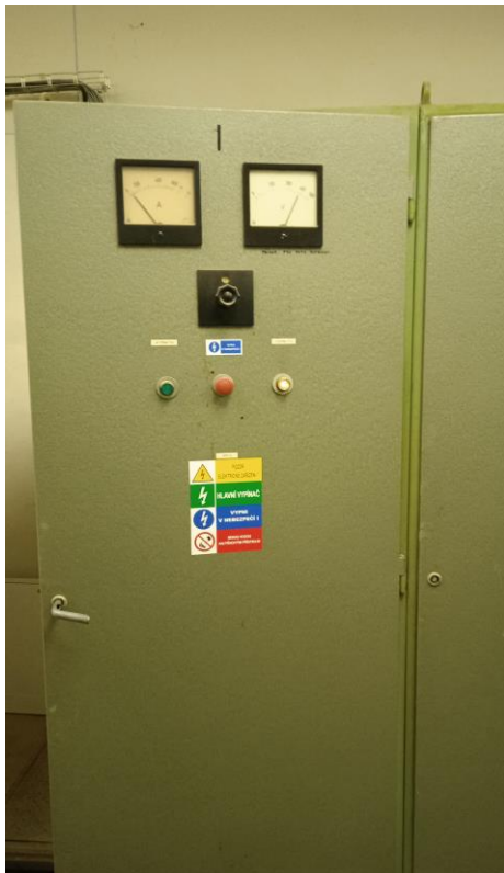
Stávající přívodní pole ( 1 ) stávajícího rozvaděče RM2, , které je předmětem rekonstrukce.
