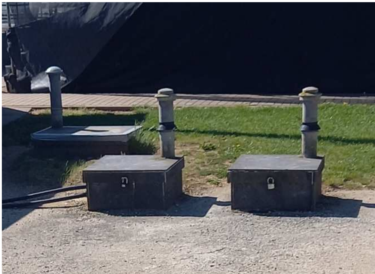
Před uložením prefa podkladní desky nutno zakrátit stávající výlezy, viz foto
