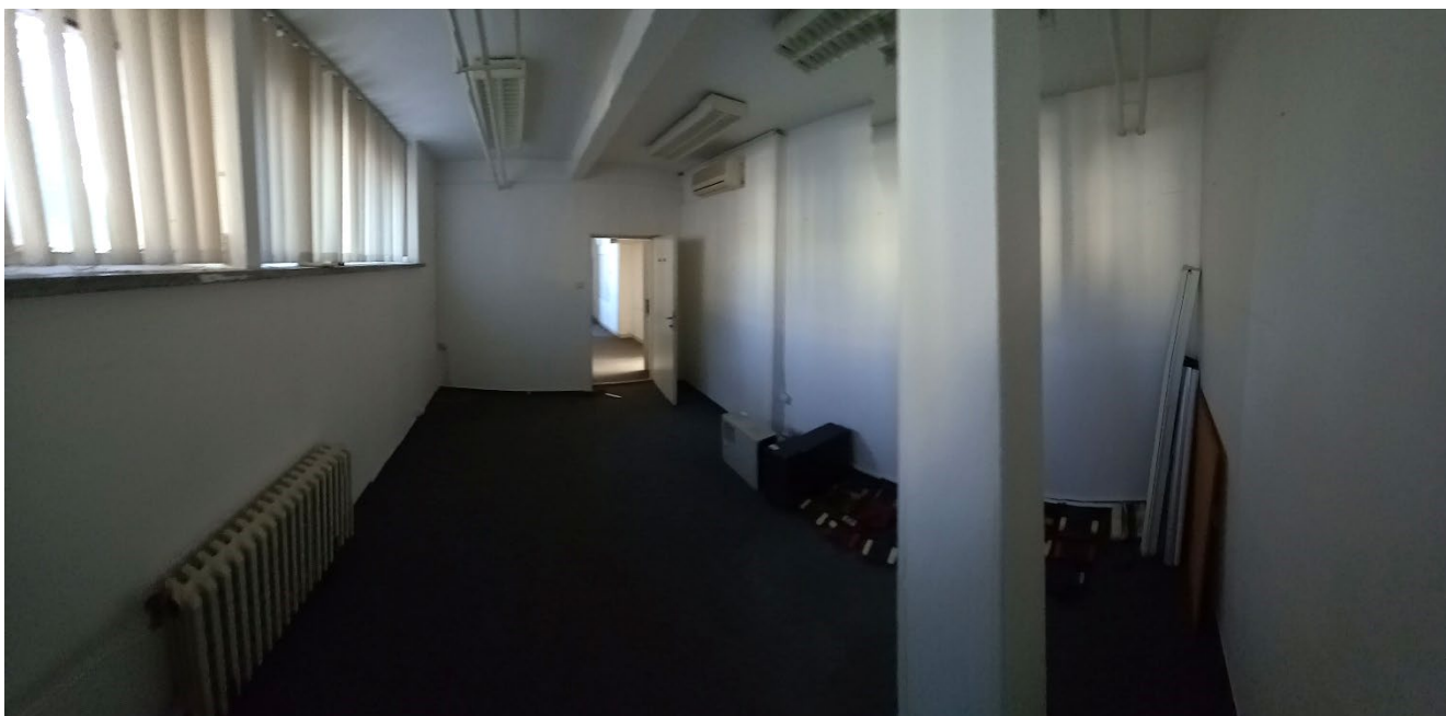
ROHOVÁ KANCELÁŘ S VIDITELNÝM DOPLŇOVANÝM OCELOVÝM SLOUPEM Z 70 LET
