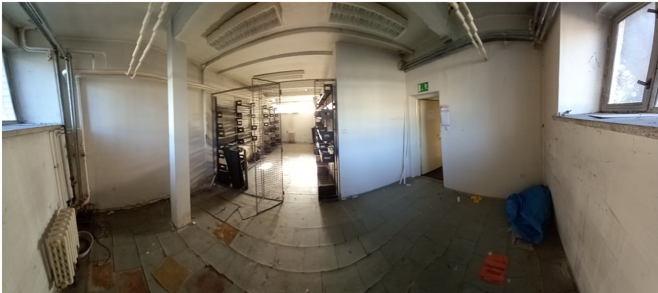
1PP - ZDIVO I VČETNĚ PŘEDSTĚN ZASAŽENO VLHKOSTÍ
