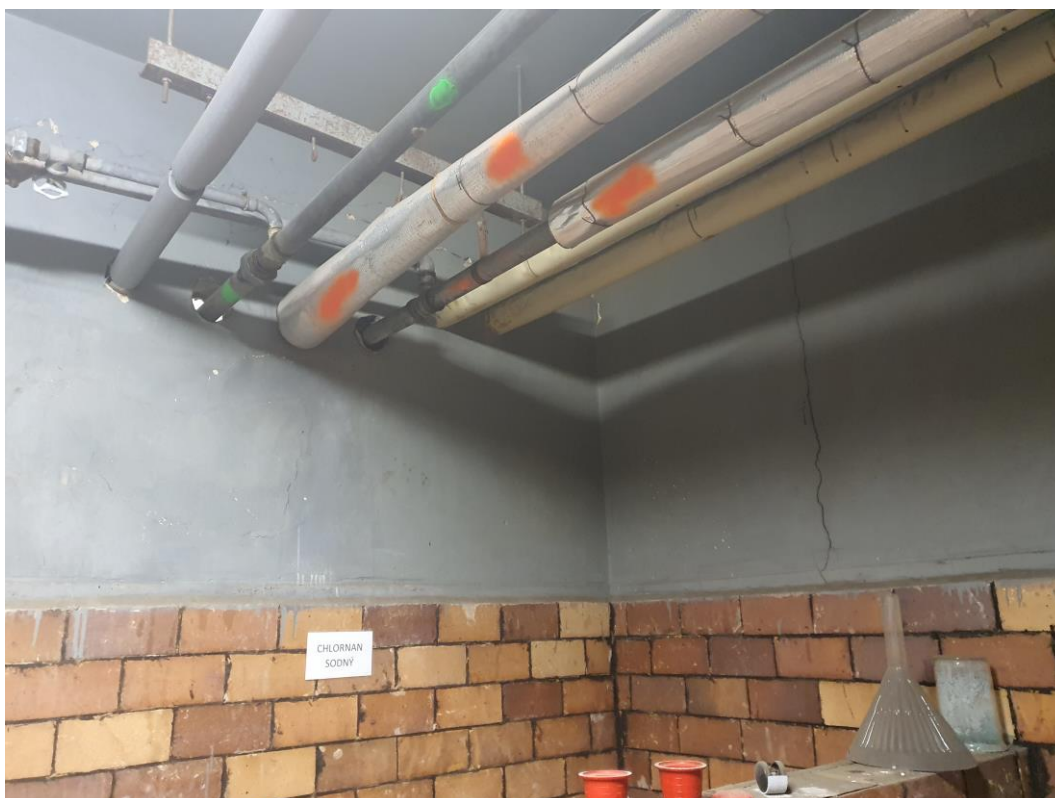
Fotografie č. 5 – Sklad chemie MPSL
