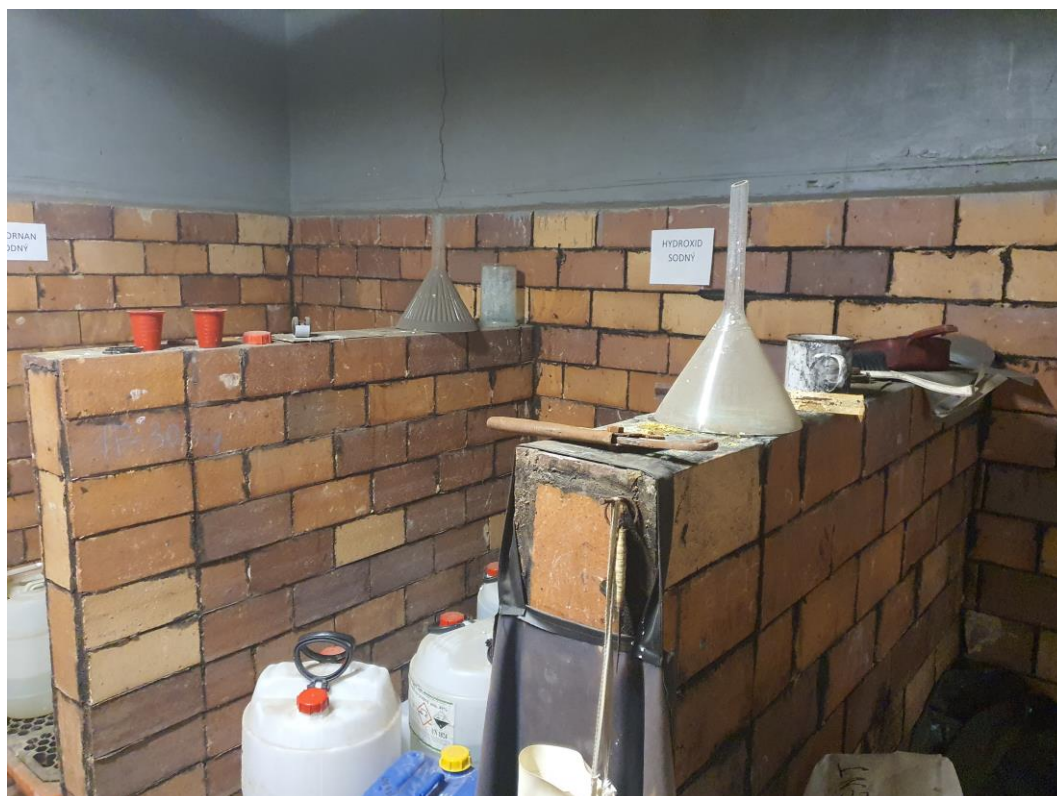
Fotografie č. 3 – Sklad chemie MPSL
